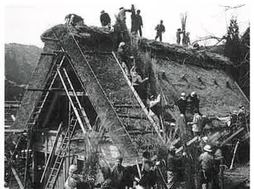
村人と力を合わせて屋根葺きを実施(白川郷合掌造り旧松井家)
