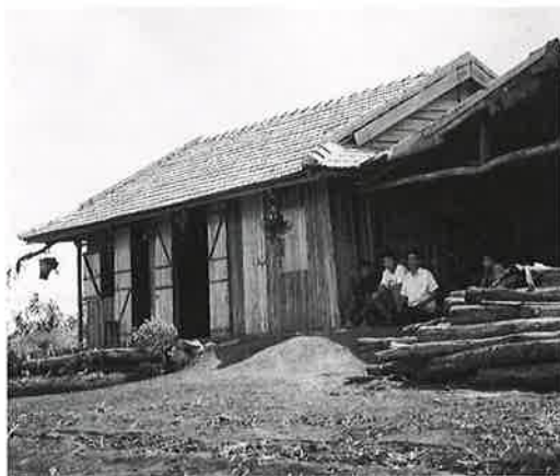
基金の助成により現地に建てられた作業事務所
