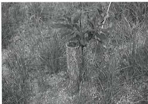
幹挿し工法によるリサイクル緑化。間伐材の幹部分を活用し、表土のない法面に直接差し込む。ホルモン剤の力を借りたが、立派に発芽
