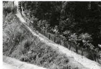
小動物保護のために設けた侵入防止柵と傾斜側溝
