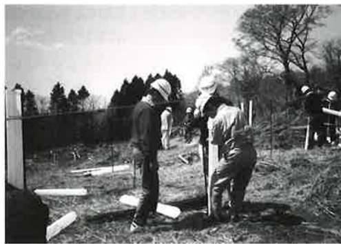
植林した苗木の両脇に支柱を立て、シカの食害よけのツリーシェルターを設置
