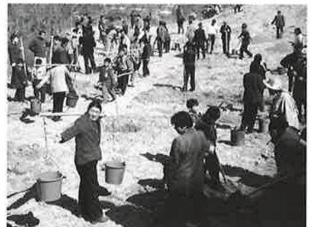
小学校附属果樹園を建設する。村の人が集まって、お祭り騒ぎになる。
