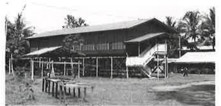
完成した「エコテック研修センター」の建屋。
