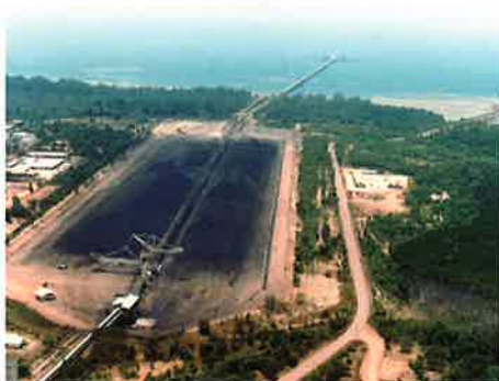
クタイ国立公園周辺は、石油や石炭、天然ガスの日本への供給基地となっている。
