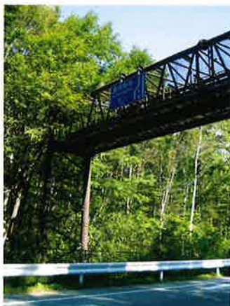
道路によって分断された生息地を結ぶ「ヤマネブリッジ」。
