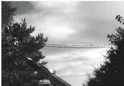
アニマルパスウェイ研究会が開発したブリッジの架設作業。
