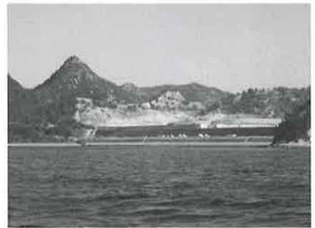
遮水壁に囲まれた豊島の産業廃棄物不法投棄現場(水ヶ浦)。
