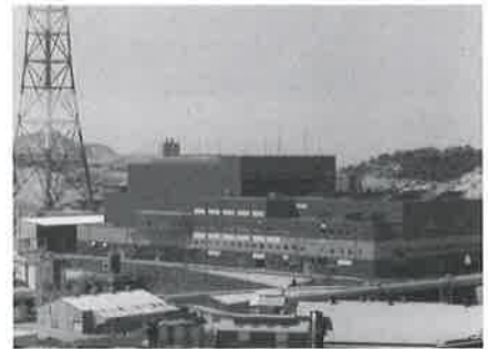
直島の三菱マテリアル(株)直島精錬所の敷地内に整備された中間処理施設。写真：香川県直島環境センター発行パンフレットより。
