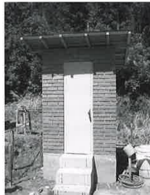
設置されたエコサントイレ。
