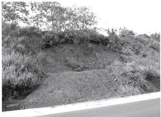
パラオ・Babeldaob島に建設された周遊道。道の側面には土壌浸食を防ぐ植林を施す必要がある/Belau Cares Inc.
