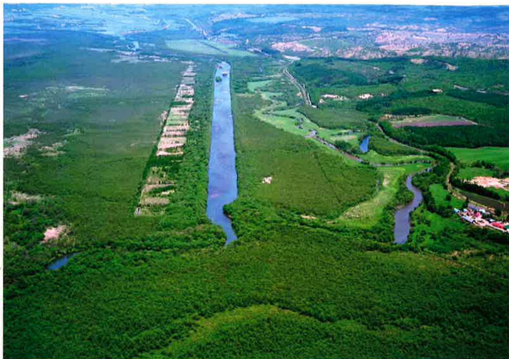
直線にした釧路川を以前の蛇行した河川に戻す工事が始まっている茅沼地区
