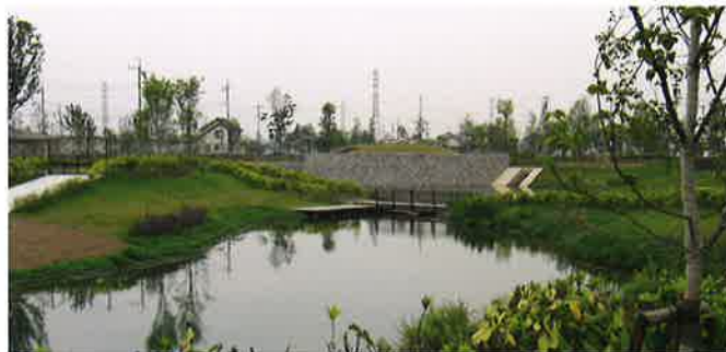
中世の円墳を多自然型調整池の一角に取り入れた(Pal Town城西の杜、群馬県太田市)
