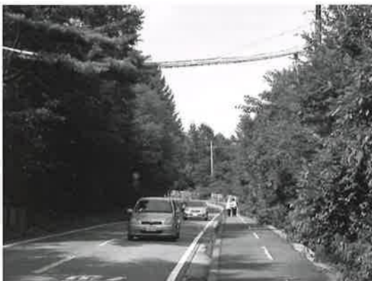
市道の建設で分断された森と森を結ぶアニマルパスウェイ
