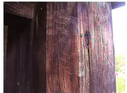
国宝の建造物の柱に付けられたアライグマの爪痕(撮影地・奈良市)
