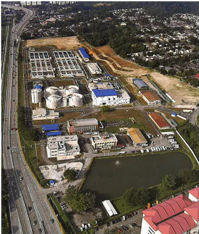
完成したマレーシアの浄水場
