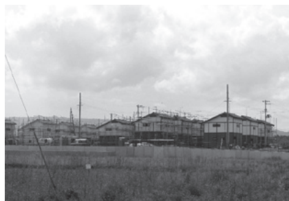
急ピッチで建設が進む災害復興住宅
