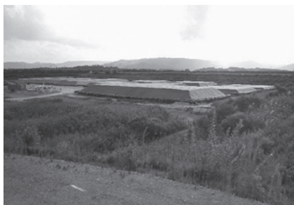
除染土仮置き場
