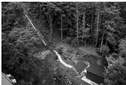
三峰川電力株式会社 夢科第二発電所
