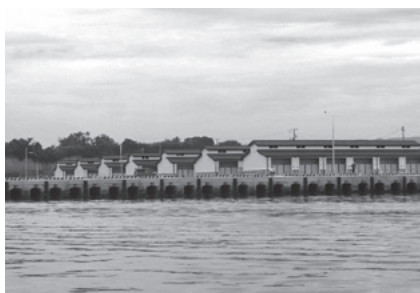
漁港脇に新設された漁具倉庫
