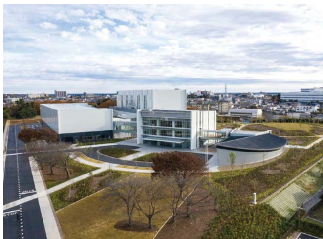
ICI総合センター（茨城県取手市）
