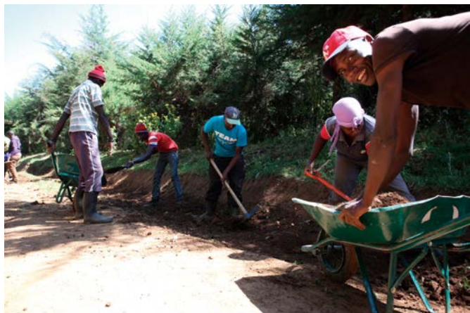
40_側溝掘削作業_道普請人
